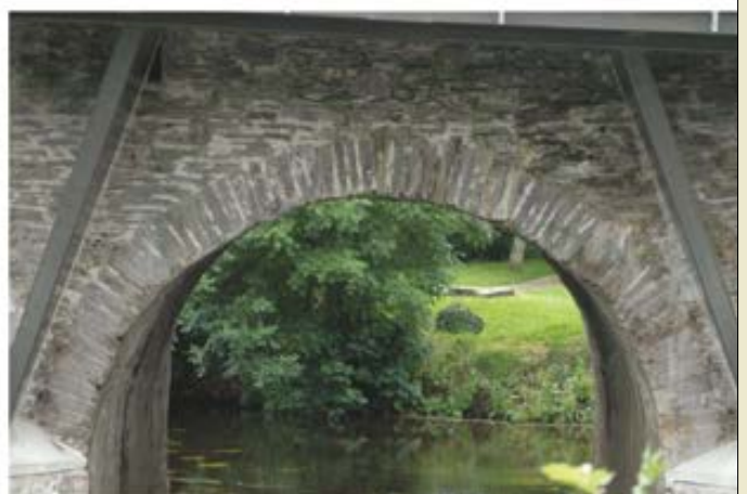
Sampla d'áirsí leathchiorclacha ar Dhroichead Mhaigh Chromtha: (barr) áirse a bhfuil a haghaidh ó dheas ar dhroichead bunaithe an 17ú haois dhéanach, (lár) áirse dhúnta a bhfuil a haghaidh ó dheas ag an cheann thiar, comhfhreagrach le hÁirse 10, agus (bun) áirse ar shíneadh thuaidh an droichid. (íomhá: Ken Hanley)
